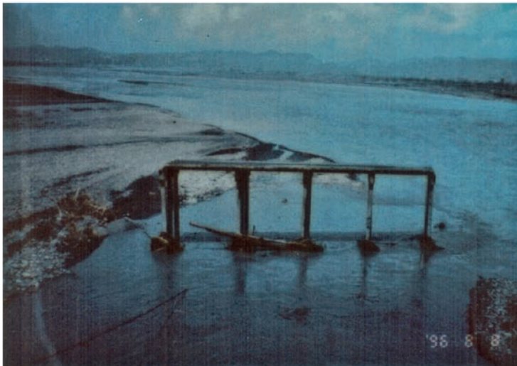
里港大橋施工舊橋前，來往車流均依賴下游約一百公尺之簡易 RC 過水橋通行；當年興建之過水橋，照片卻呈現高橋墩之景象，可見高屏溪河床下陷問題嚴重。
