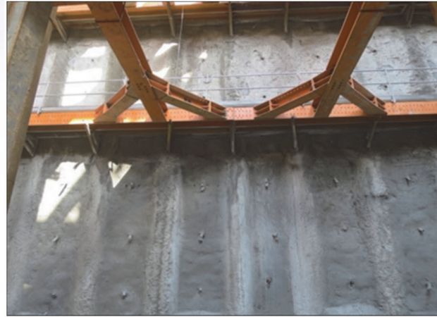
圖 13 全套管擋土樁間掛網完成後噴凝土施工
