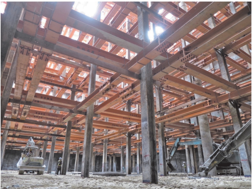
圖 10 臺中捷運綠線 G9-1 站 36.75 m 開挖完成
