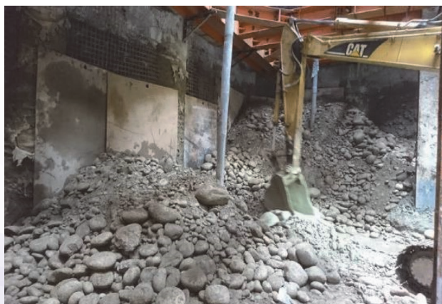
圖 14 以鋼板組模回填灌漿穩定開挖壁面
