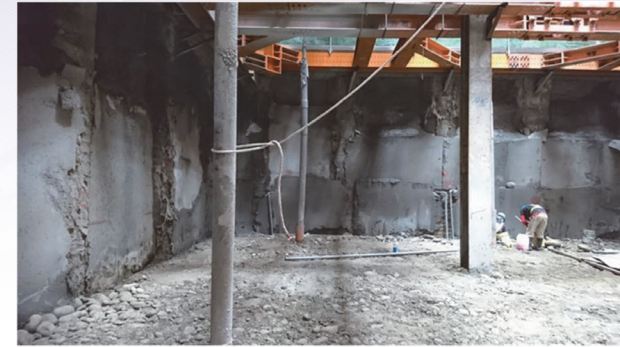
圖 15 開挖壁面設置排水管線後集中排出
