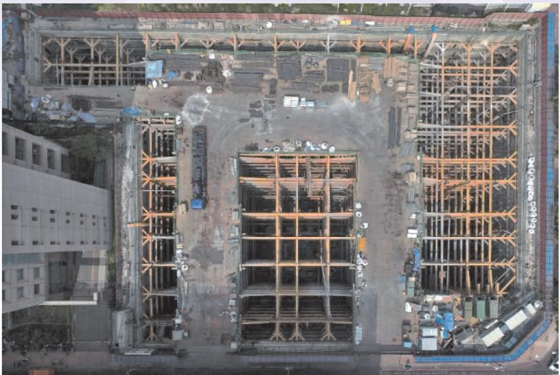
圖 9 臺中捷運綠線 G9-1 站開挖完成空拍圖
