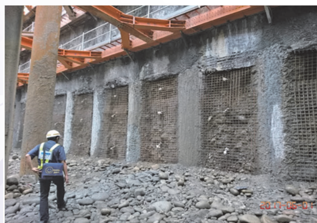
圖 12 全套管擋土樁間掛網施工
