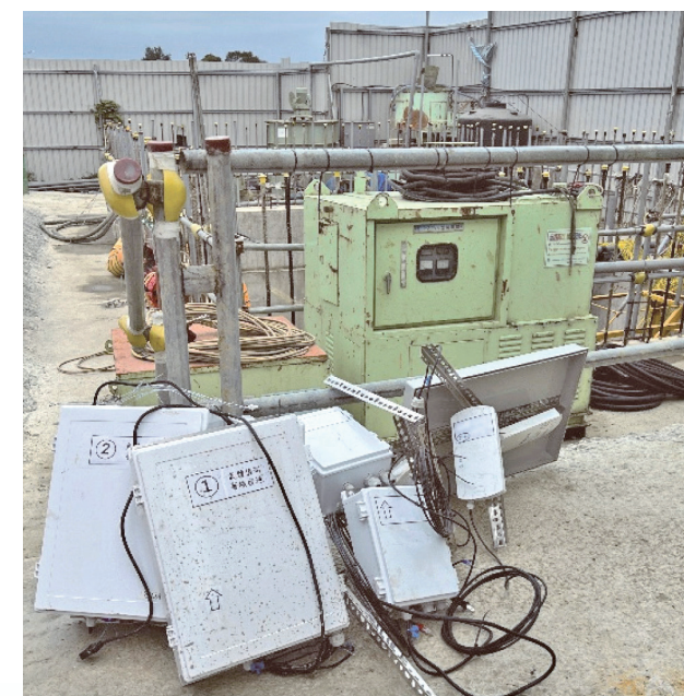
圖 12 本案例設備卸除後照片
