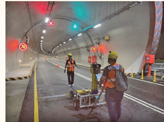
(1) 主線隧道掃描作業
