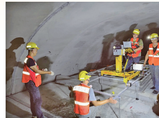
(3) 通風管道掃描作業
