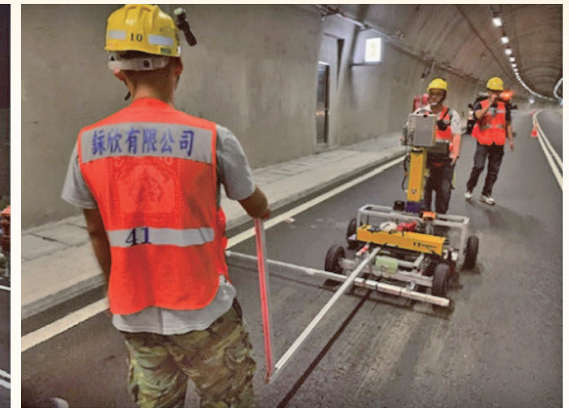
(2) 通風管道掃描作業
