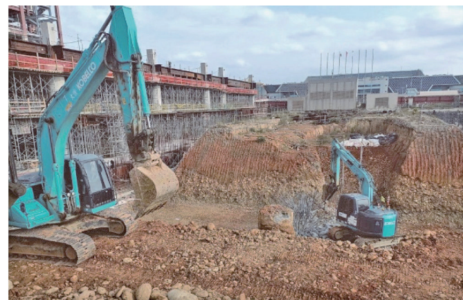
圖 7 潛盾隧道上方斜坡明挖
