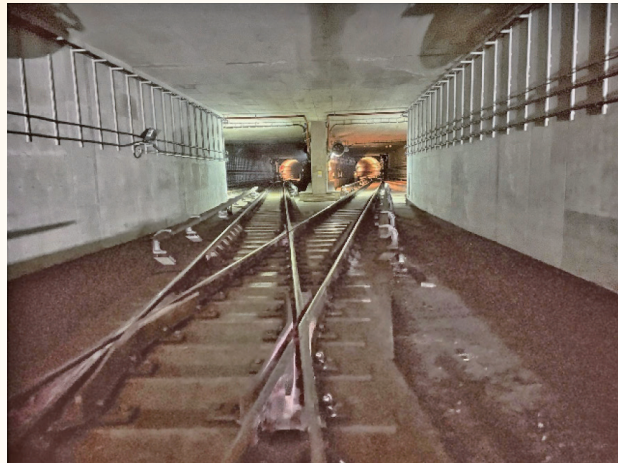
圖 3 潛盾段與明挖覆蓋段交接處
