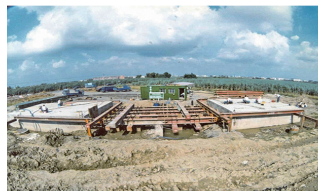
圖 22 2000T 群樁側向載重試驗全景 (1997, 高鐵研究案, 台安技術提供)
