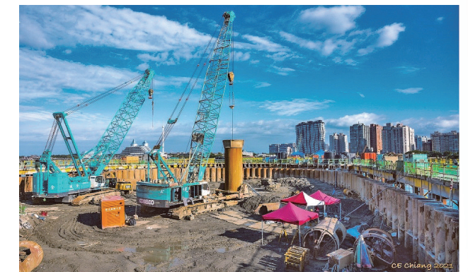
圖 3 淡江大橋主橋塔之全套管樁施工（江政恩攝）
