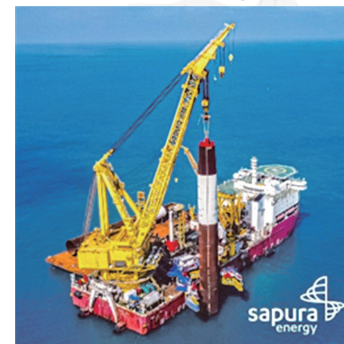
圖 12 Monopile 施工船機 (摘自 Sapura，中興顧問提供)
