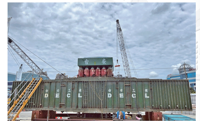
圖 18 壁樁 4800T 拉力載重試驗（2026，台安技術提供）
