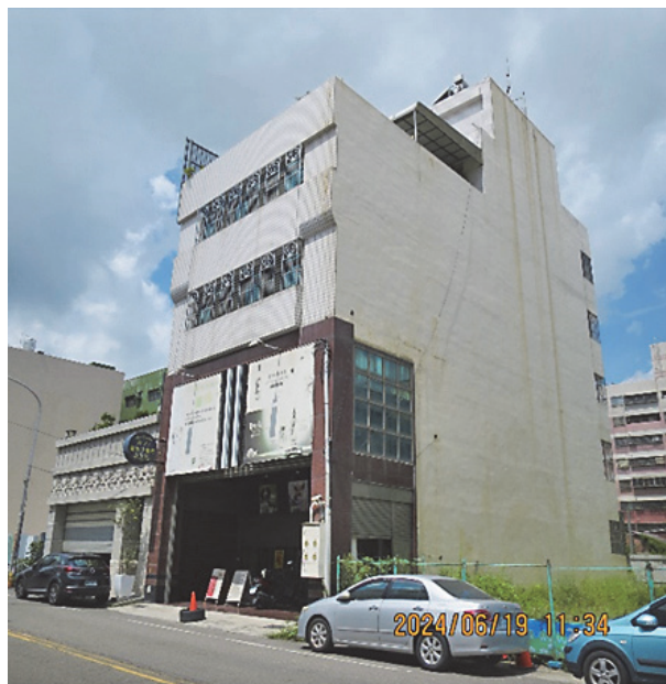
圖 7.2-19 員林大同路一段 19 號獨棟 4 樓建物
