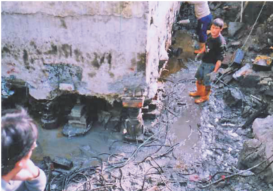
圖 7.1-1 以千斤頂頂升傾斜基礎施工情況
