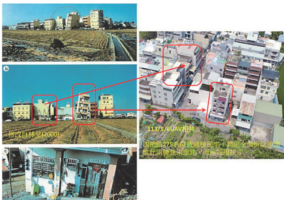
圖 7.2-12 霧峰四德路獨棟民宅傾斜扶正照片
