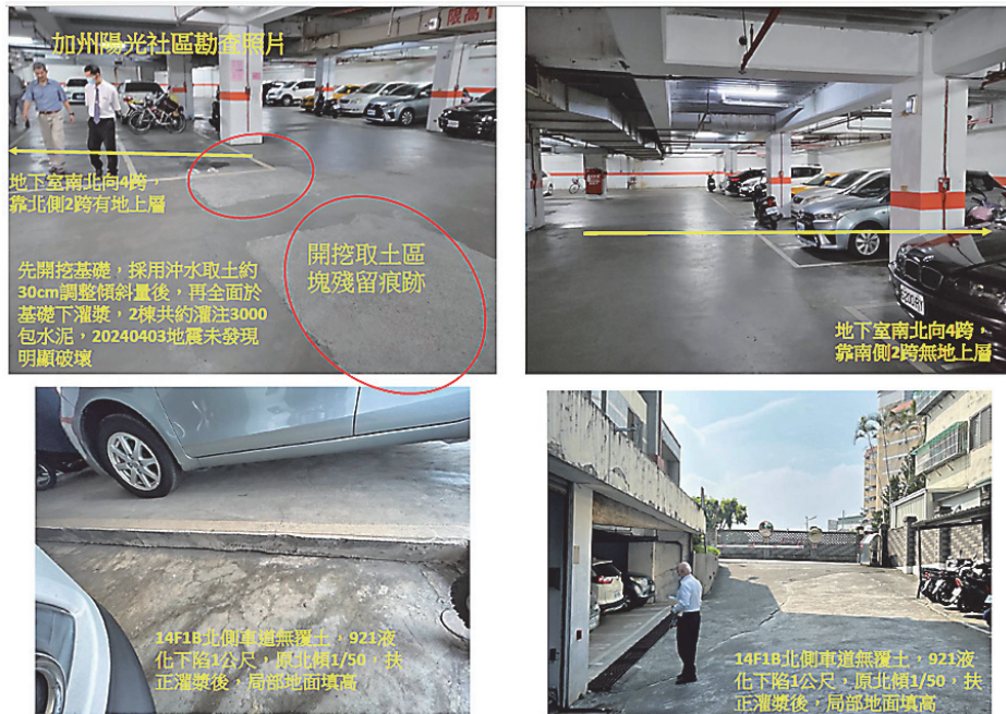
圖 7.2-7 加州陽光社區建物扶正與基礎改良措施情況
