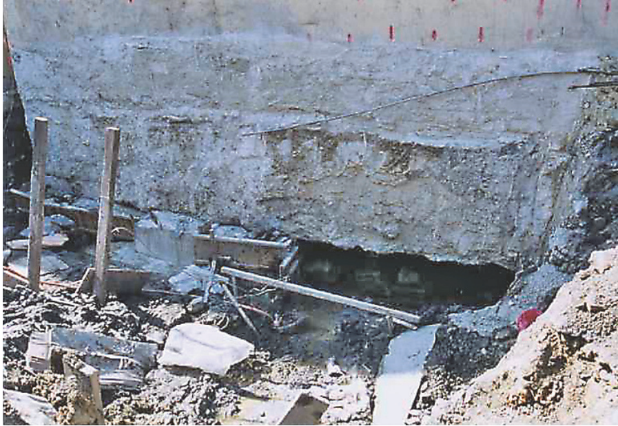
圖 7.1-2 於頂升工法扶正基礎後再以 RC 座在原基礎下方補強
