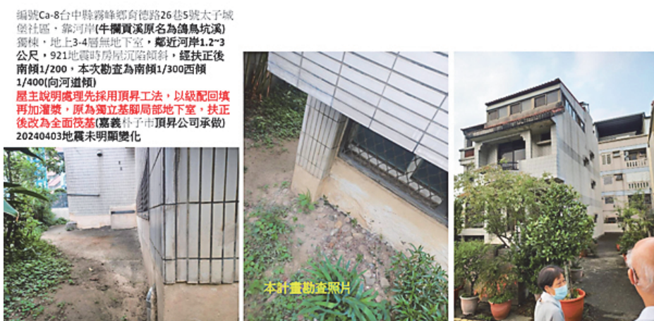
圖 7.2-17 霧峰育德路 26 巷 5 號建物修復及改善現況
