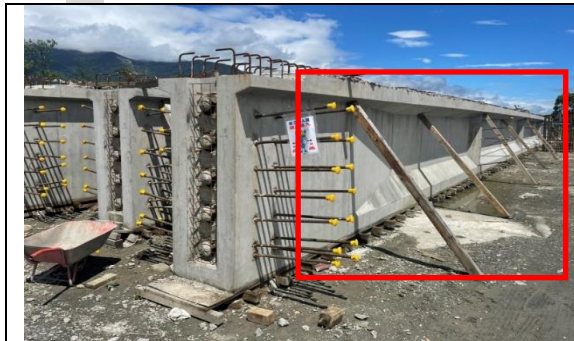
照片 5：吊放前-斜撐可均佈於梁身
