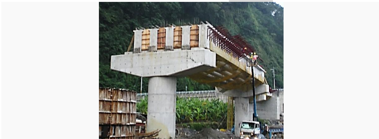
圖 8 端隔梁現場施工圖
