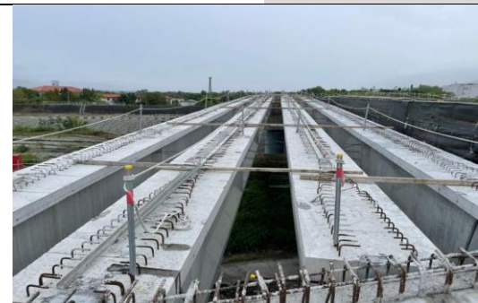
照片 8：吊放後-木料角材橫向連結
