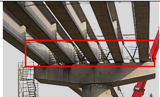
照片 6：吊放後-斜撐只於兩端帽梁
