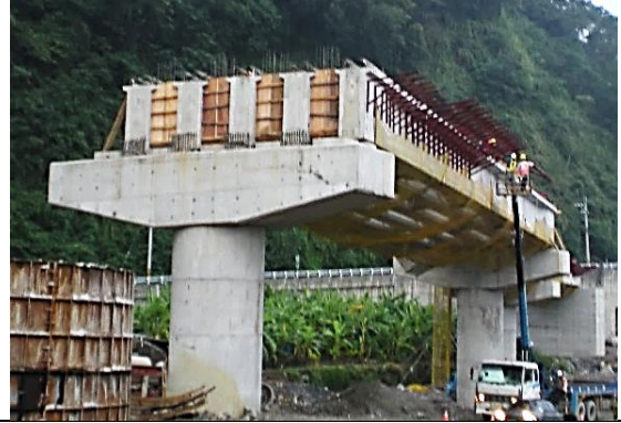
照片 10：預力梁吊放後隔梁施工中
