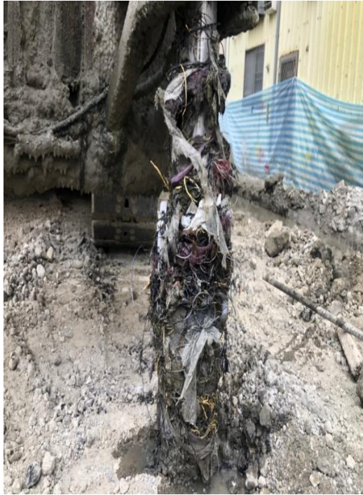
圖 26 地質改良樁施作時發現鐵絲及垃圾
