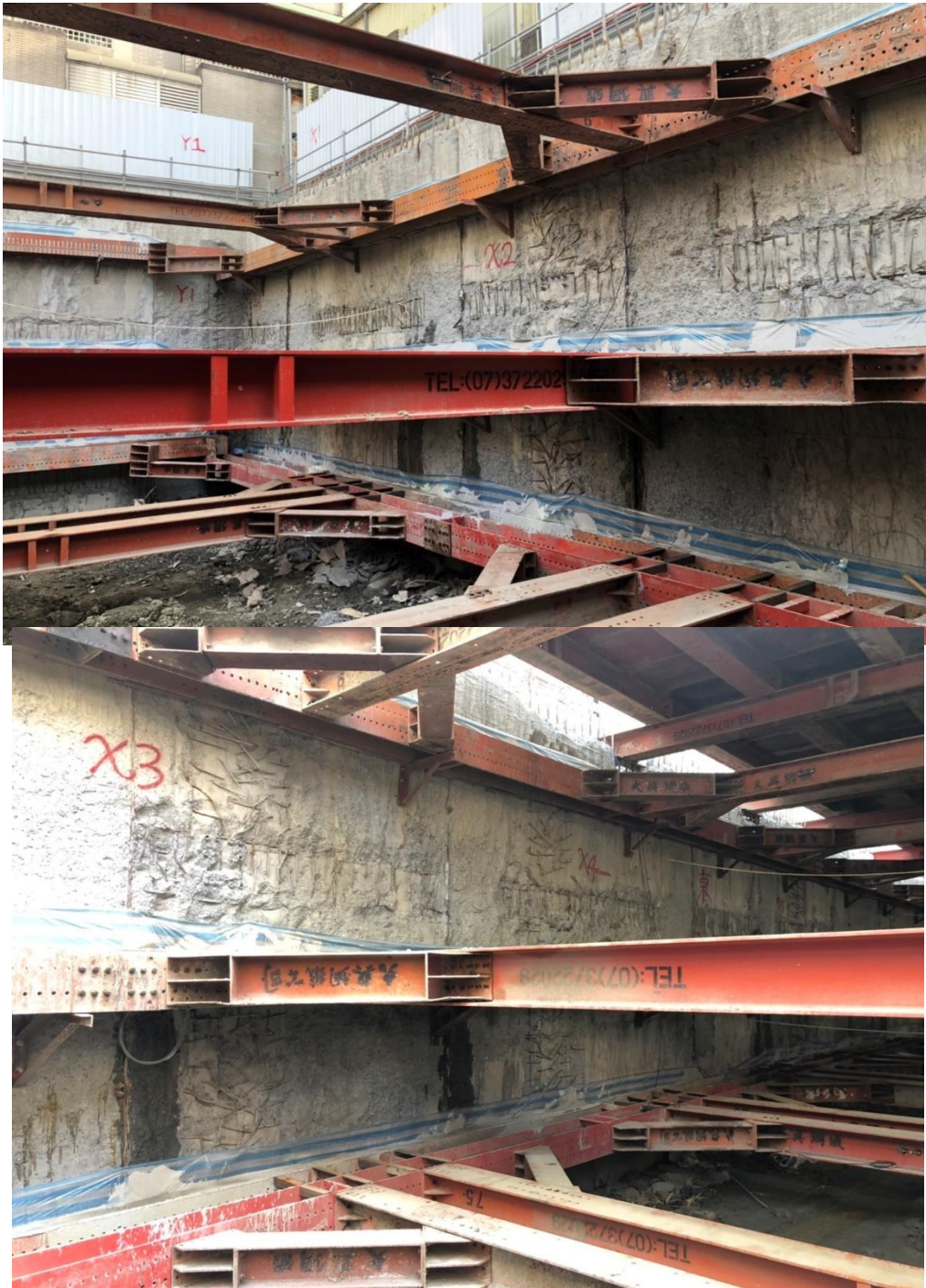
圖 30 連續壁面潔淨(表面為預留鋼筋)
