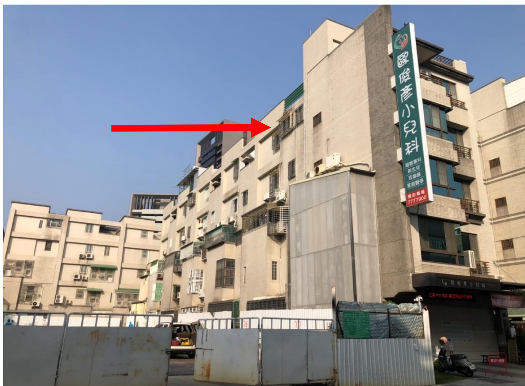
圖 14 工區與東側鄰房相對位置
