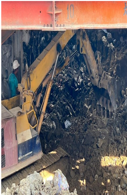
圖 28 開挖時挖出垃圾廢棄物情況(破磚塊、木塊)
