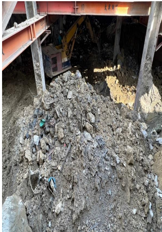
圖 27 基地開挖時挖出大量垃圾寶特瓶廢棄物
