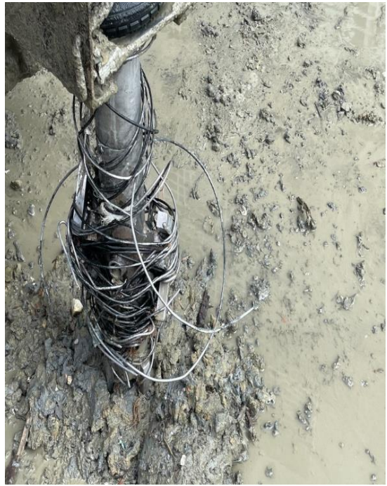
圖 26 地質改良樁施作時發現鐵絲及垃圾
