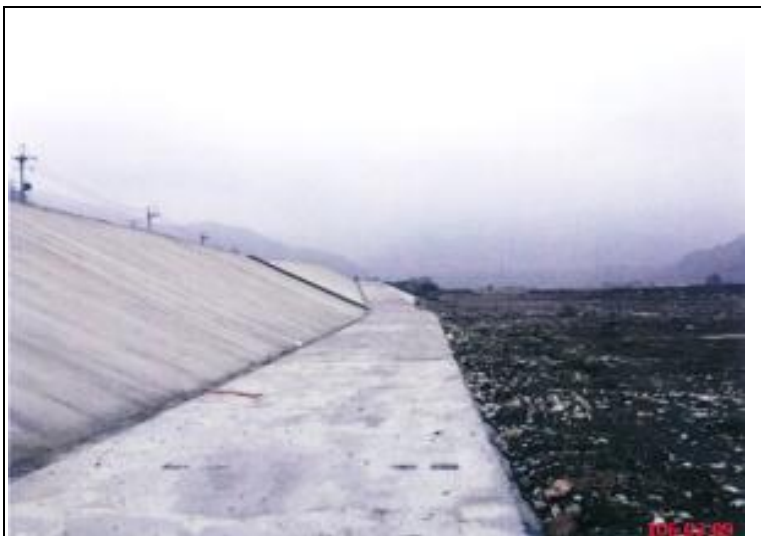
圖 6-3-1 102 年蘇力颱風後白布帆堤防搶修工程
